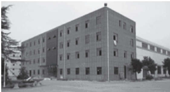
中国新和信 建設中の事務所棟と工場
